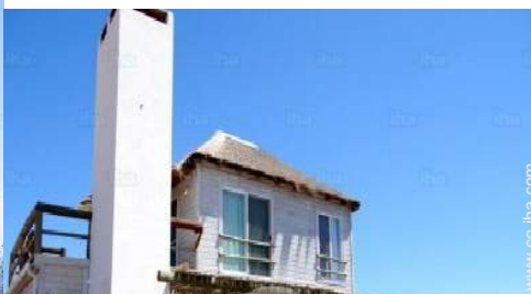
vista de conjunto
