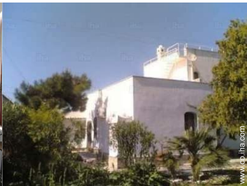
vista de conjunto
