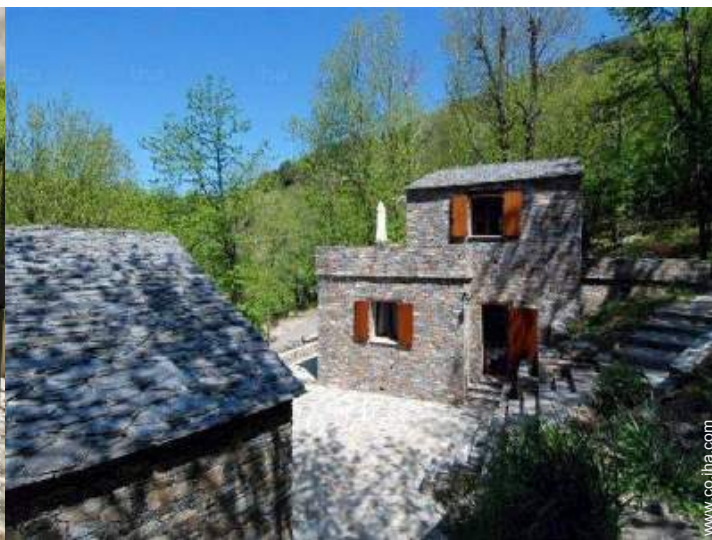
vista de conjunto
