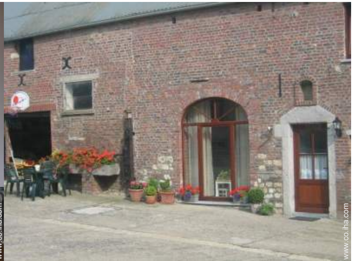
vista de conjunto
