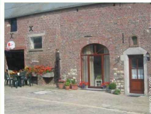
vista de conjunto
